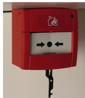
4. ábra A jelzésadó működési próbája
